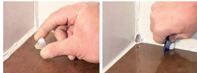
Das Kleinteil wird ganz einfach im Eck auf das Silikon platziert.
